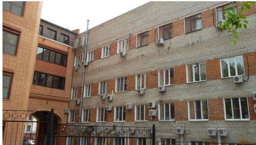
Фото 8 Нежилое помещение четырехэтажное
