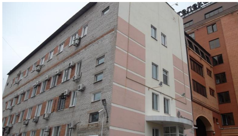
Фото 6 Нежилое помещение четырехэтажное
