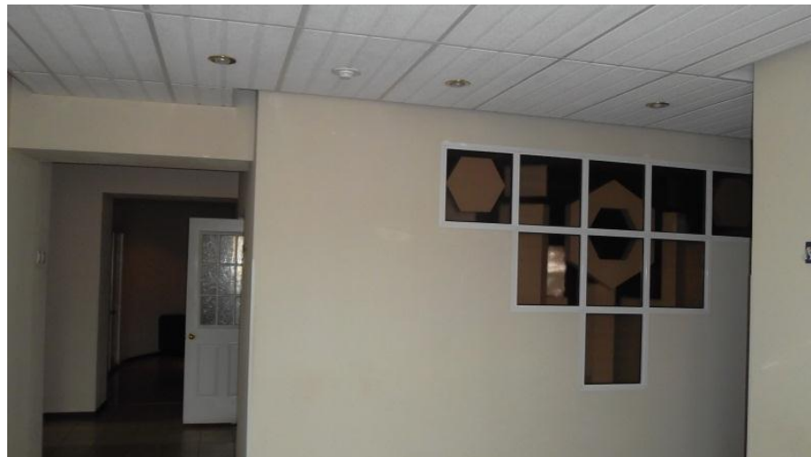
Фото 30 Административное здание 8 этажное 6 этаж
