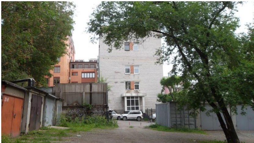
Фото 7 Нежилое помещение четырехэтажное
