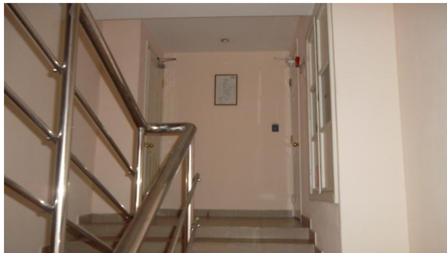
Фото 32 Административное здание 8 этажное 8 этаж
