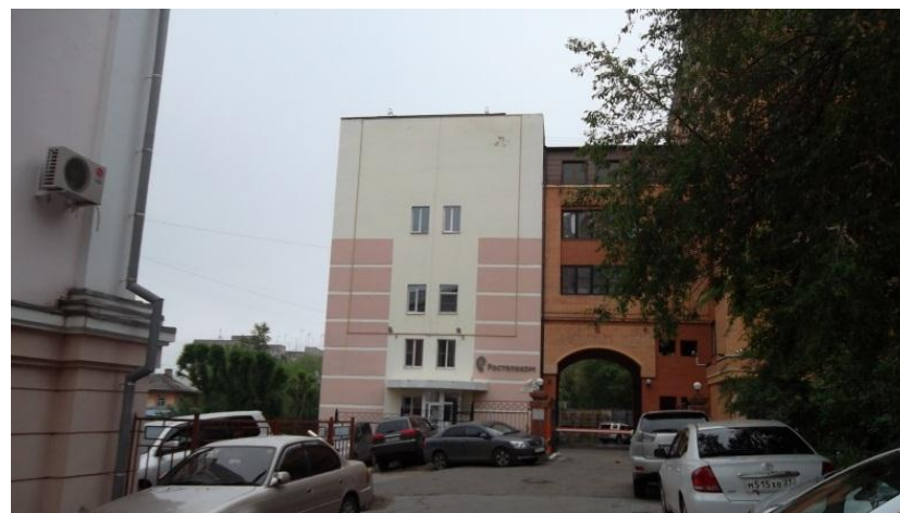
Фото 4 Нежилое помещение четырехэтажное
