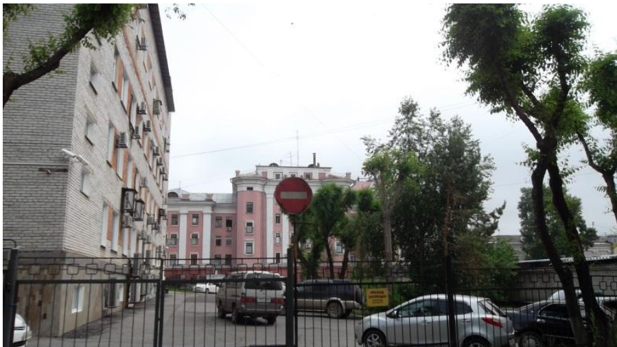
Фото 9 Нежилое помещение четырехэтажное
