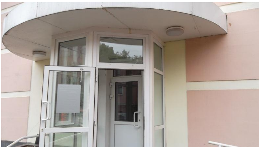
Фото 5 Нежилое помещение четырехэтажное
