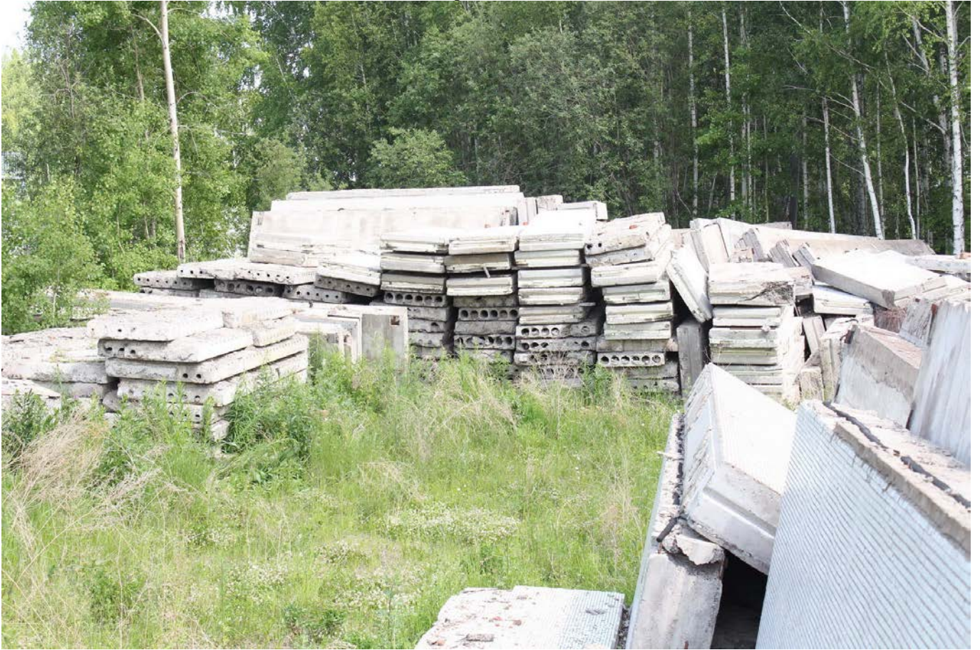
Общий вид хранения плит ПК 57
