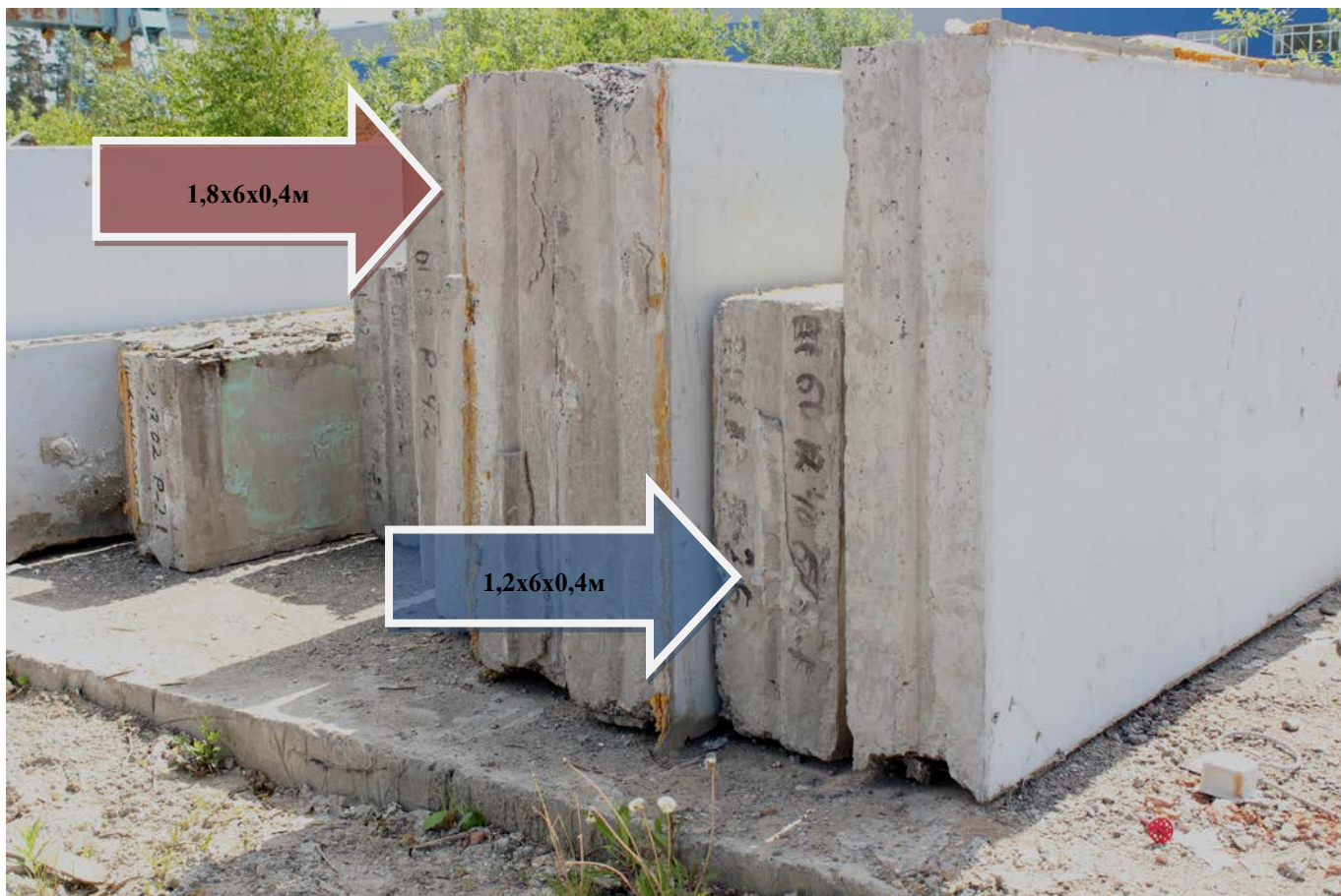
Панели стеновые керамзитобетонные размером (1,2х6х0,4м; 1,5х6х0,4м; 1,8х6х0,4м)
